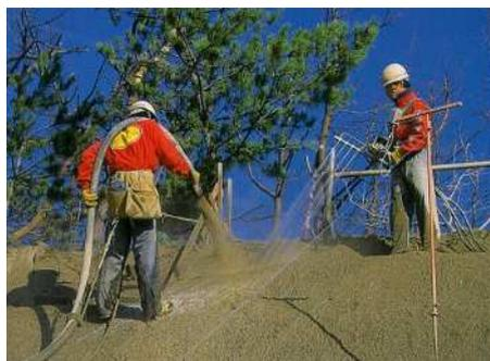
図 2-2 ジオファイバー工法の施工状況
