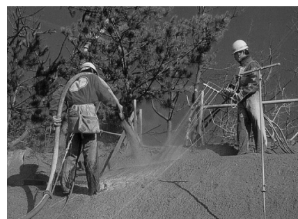
ジオファイバー工法の施工状況 (連続繊維補強土造成工)
