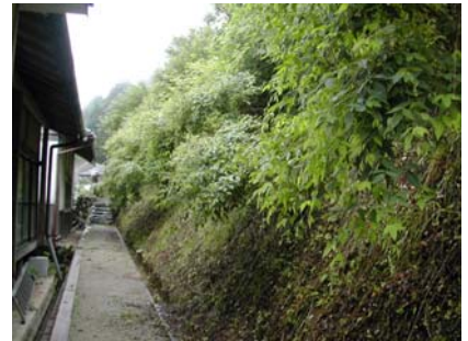
裏山も緑の法面
