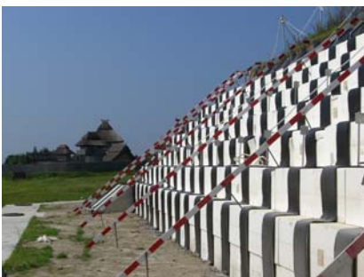
豪雨時の排水対策に排水シートを1m間隔に配置(黒の帯状に見えるもの)
