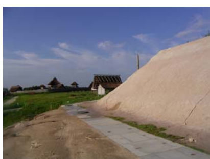
連続繊維補強土工施工完了
