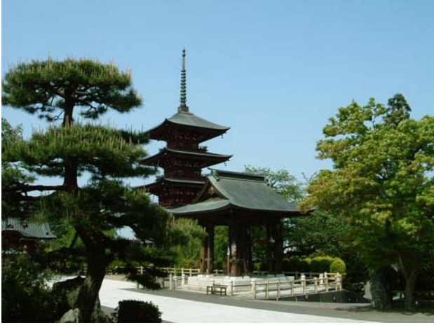
文化財寺院周辺法面に施工
