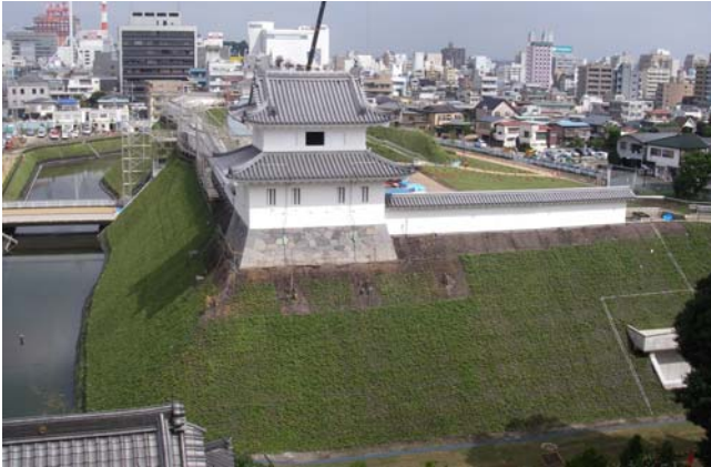
連続繊維補強土の施工
