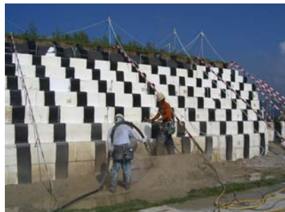
連続繊維補強土の築造状況(2006年8月)
