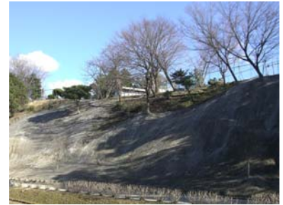
連続繊維補強土工施工完了
