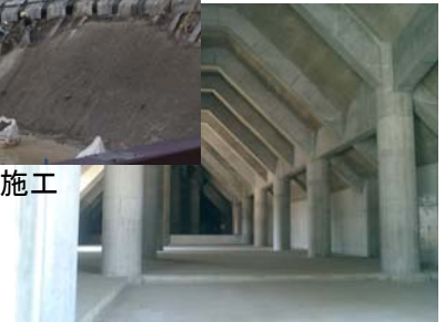
土塁の内部は資料館
