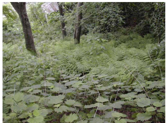
アカソやシダで覆われた法面
