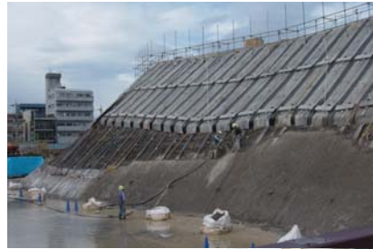
連続繊維補強土の施工
