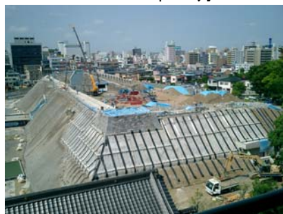
連続繊維補強土の築造状況
