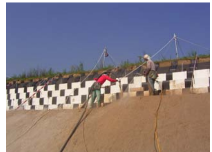
連続繊維補強土の築造状況(2006年8月)
