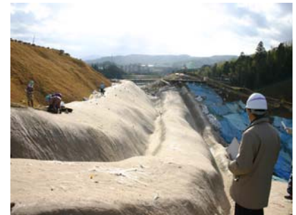
連続繊維補強土施工状況
