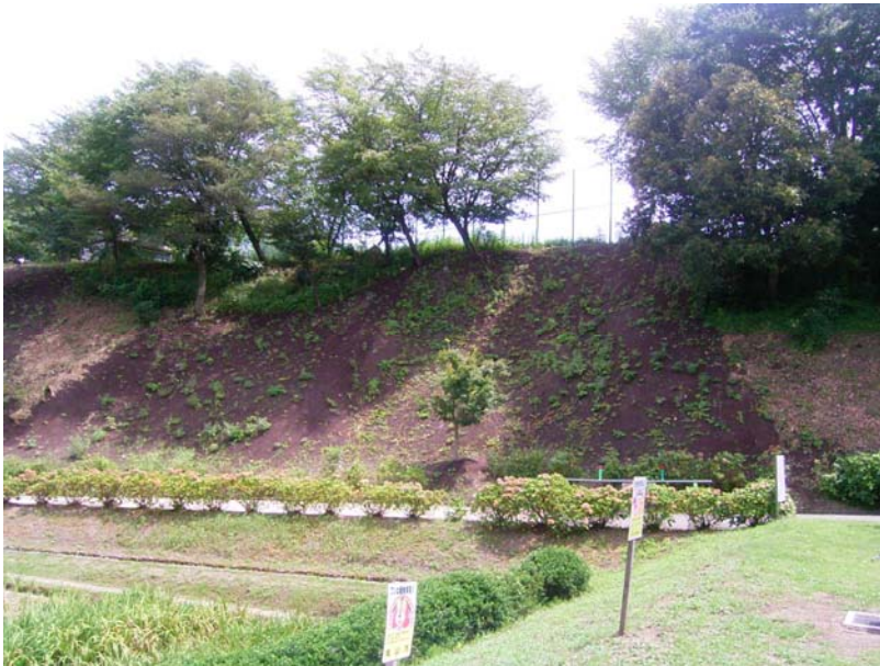
施工4ヶ月(2007年8月)
