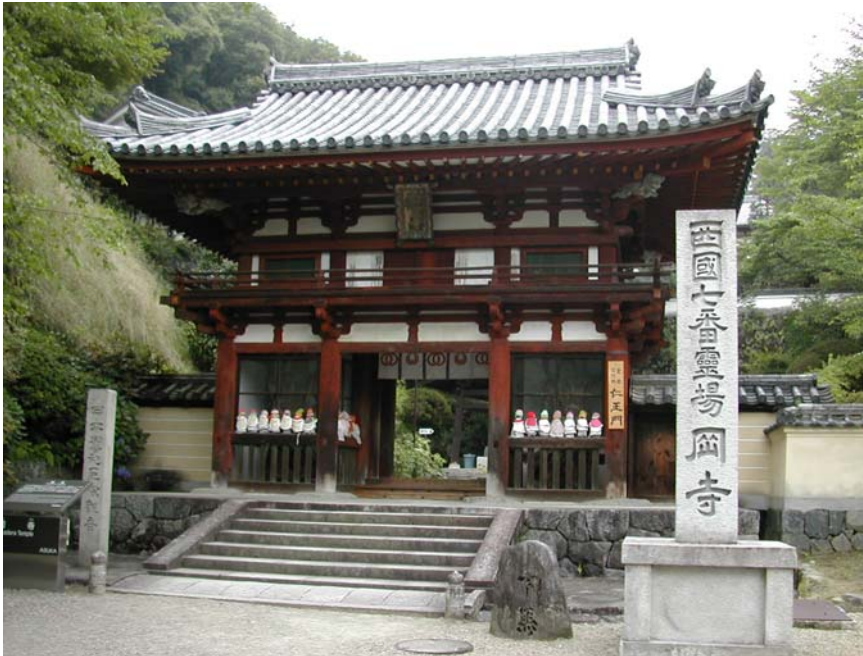
岡寺仁王門左の法面 施工後6年(2007年6月)
