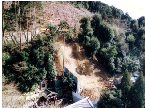
土砂崩れ崩壊斜面
